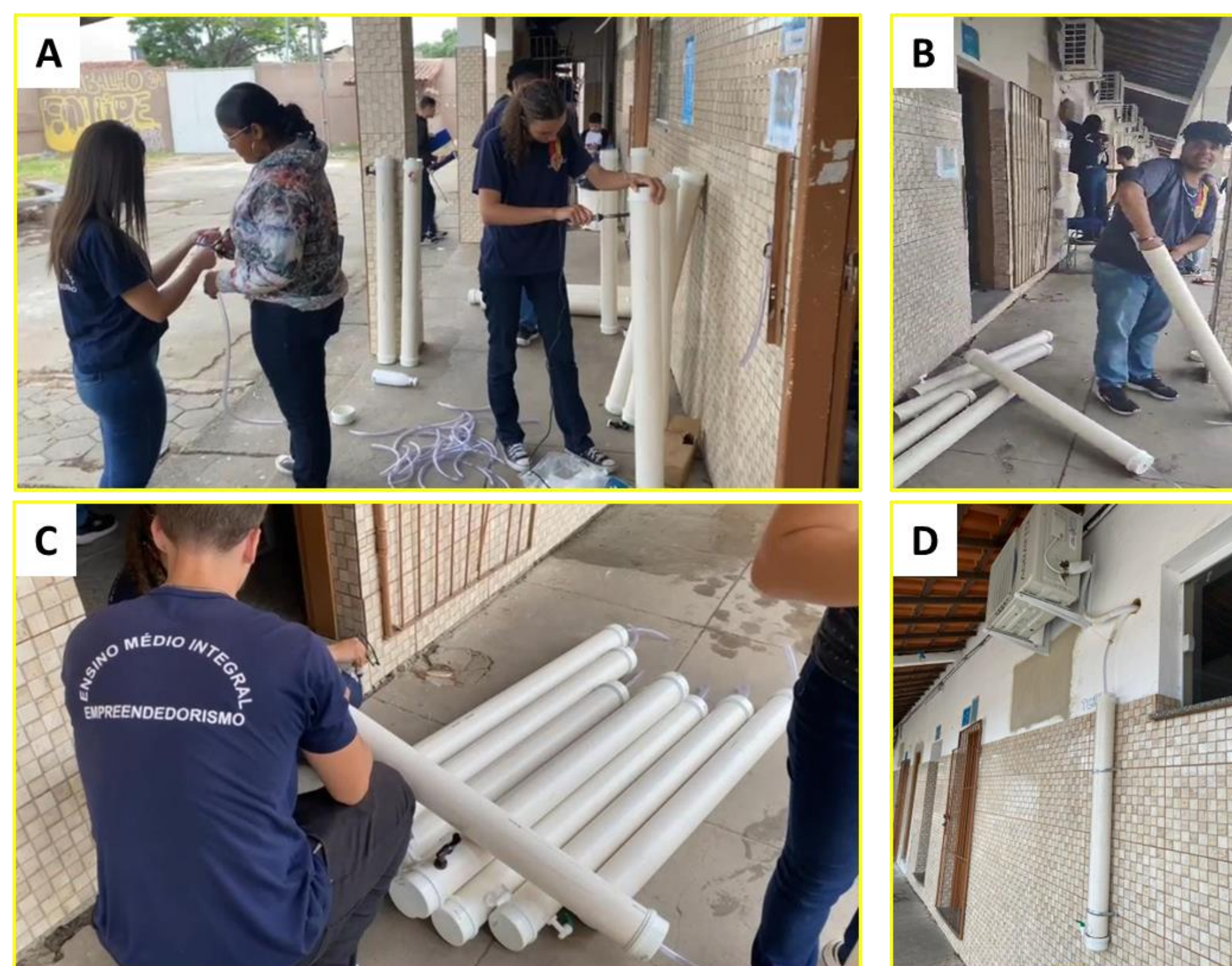
Figura 1. A-D Fotos das confecções e instalações dos reservatórios.
