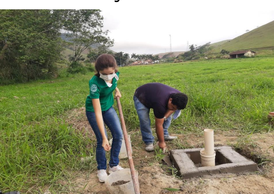
Foto 7 – proteção do poço Para colocação da bomba
